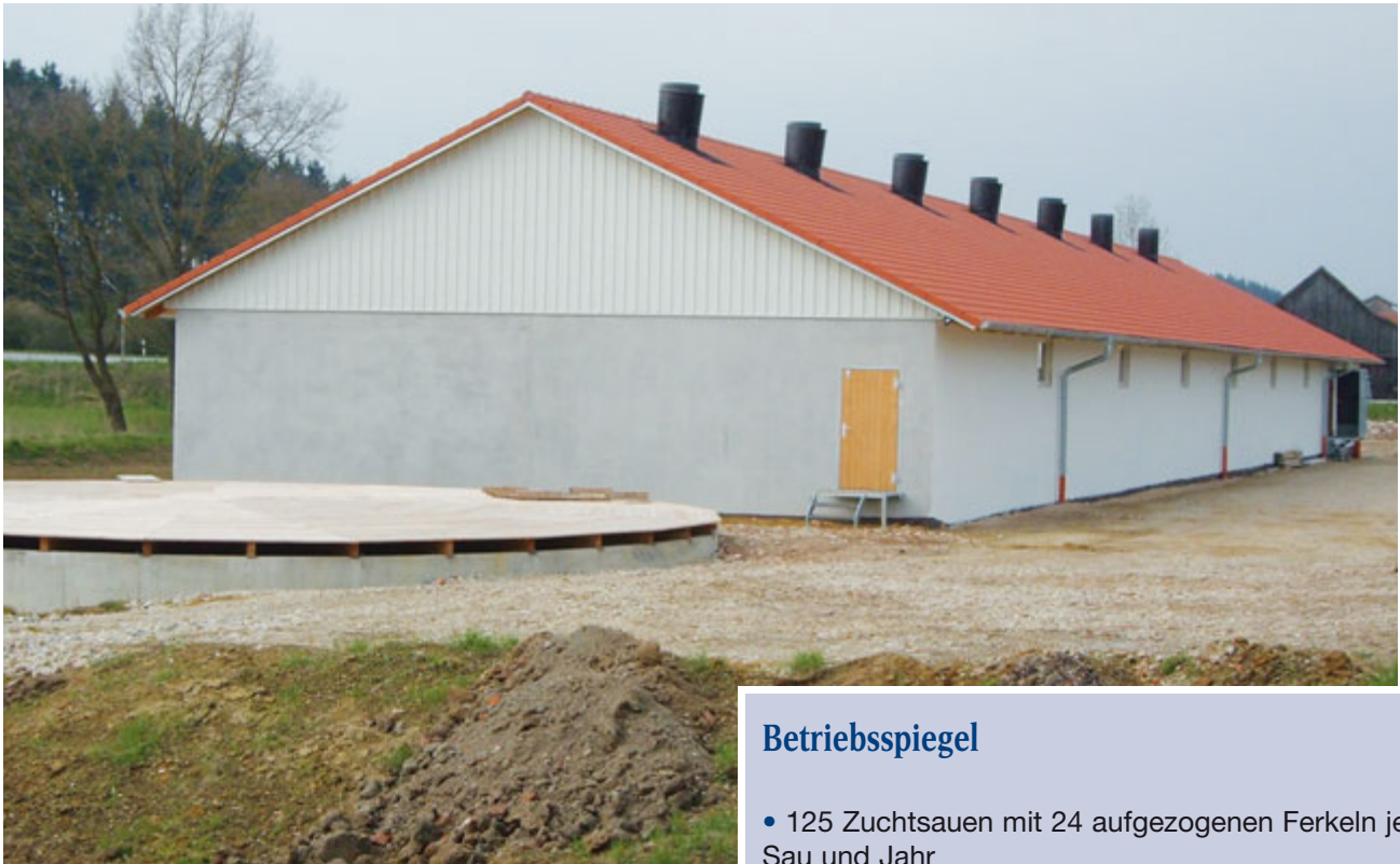
Neuer Maststall mit 700 Mastplätzen, die durchschnittlichen täglichen Zunahmen liegen bei 860 g.
