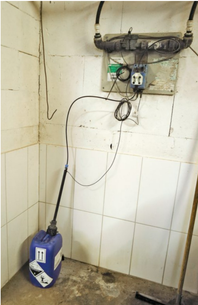
Über die Dosierpumpe gelangt die Impfstoff-Stammlösung in die Wasserleitung. So impfen sich die Tiere beim trinken quasi selbst. Arbeitswirtschaftlich ist das sehr günstig.
