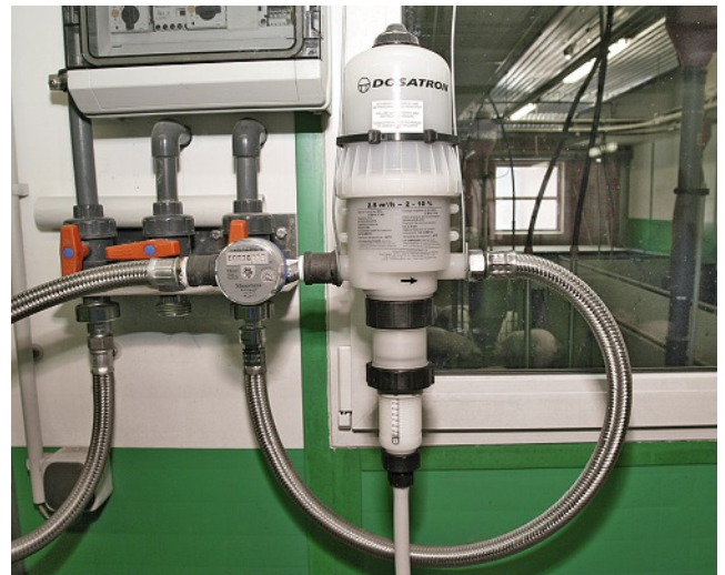
Impfung übers Trinkwasser mit Dosiergerät
