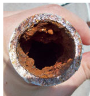
So nicht: Eine Ablagerung von Eisenoxid in Metalleitung mit Bildung von Biofilmen sollte unbedingt vermieden werden.
